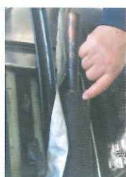
▲銅線部分が太い場合も同様に剥離できる
