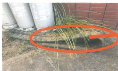
▲ミニショベルのゴムクローラーの金属部分を剥離するケース
