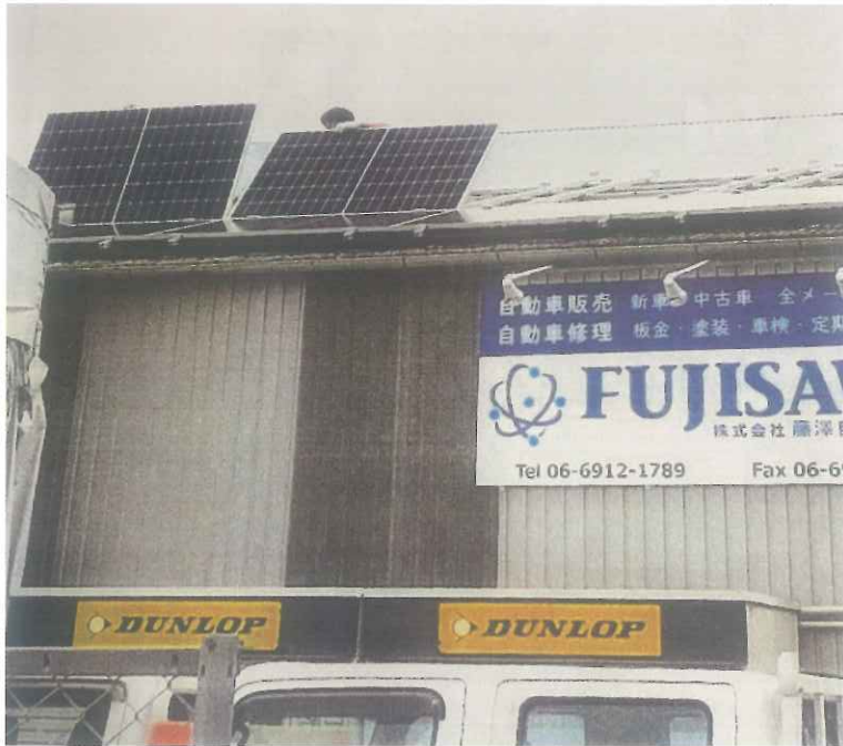
▲藤澤自動車工業所のパネル設置工事の様相
