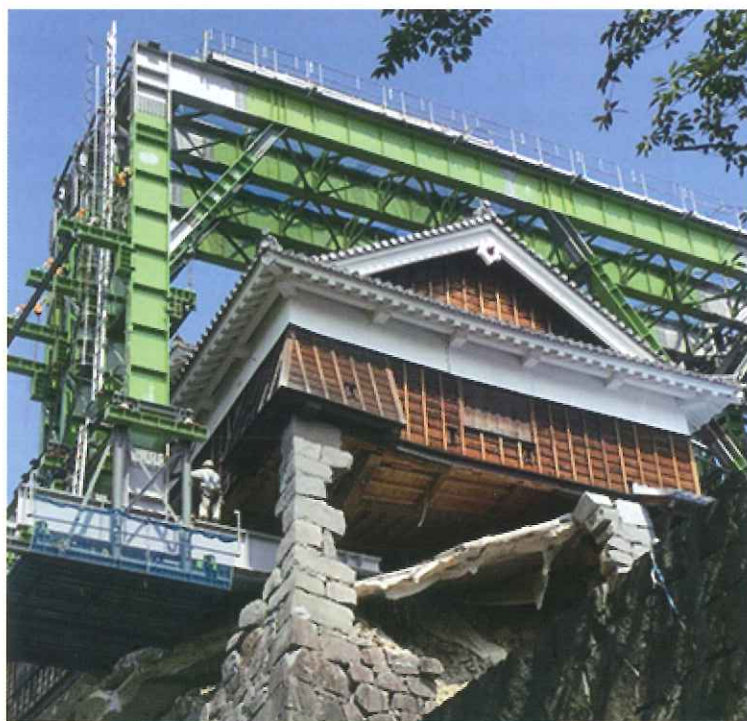
▲修復工事が始まっている熊本城(株大林組のHPから)
